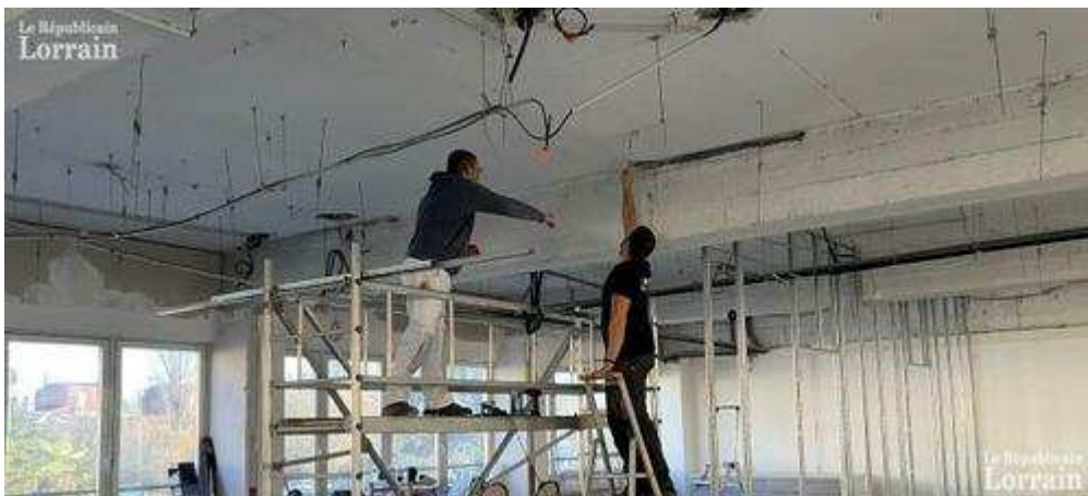
L'absence de murs porteurs permet d'adapter les lieux aux besoins des équipes, sans contraintes. Photo RL /Aurélie KLEIN
